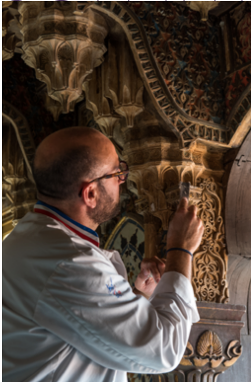
LA GYPSERIE - RESTAURATION DU MUSÉE PIERRE LOTI SUR ROCHEFORT 17 D'ÉLÉMENTS MOULURÉS EN STAFF © GUILLAUME DE LAUBIER
