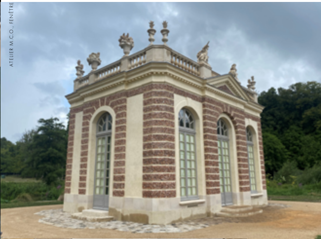
ATELIERS CHOLLET FRÈRES, RESTAURATION DU PAVILION SUR L'ÎLE - CHATEAU DE DAMPIÈRE EN YVELINES © ATELIERS CHOLLET FRÈRES
