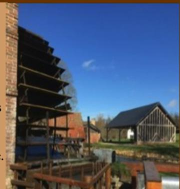
Les aubes du moulin, en chêne, ont été fabriquées en 1988. Certaines se sont cassées avec le temps mais ont été remplacées. On les pose sur la roue "brutes de sciage" c'est-à-dire juste après le sciage, en planches, et on les met directement dans l'eau. Elles dureront ainsi plus longtemps : 20 ans en moyenne.
